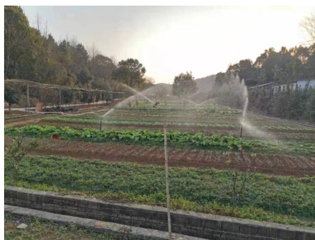
水肥一体化输送管网
